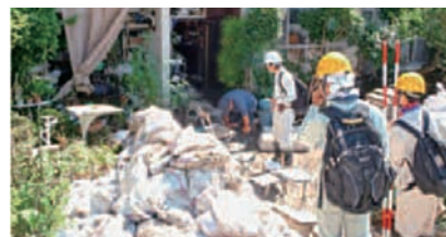
災害現場の調査
