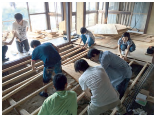
床の改修作業の様子
