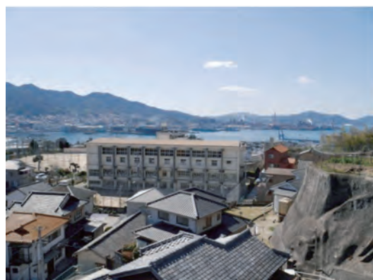
石段の家から呉港を望む
