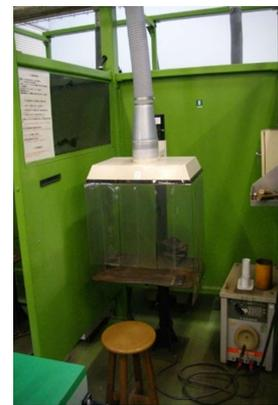
写真2 溶接場の排気設備
