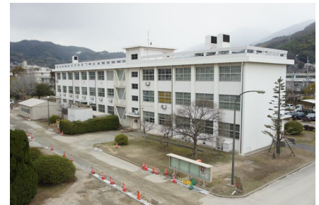
調査対象建築物全景
